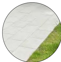
Terrasse Fast belægning af betonfliser
