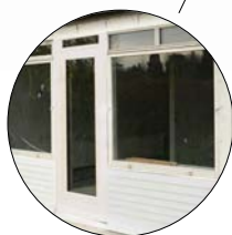
Vestfacade Hele facaden i hvidmalet træbeklædning med store vinduer
